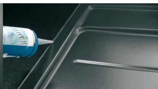
Silikonieren: Hierbei darf nur wasserfestes, neutral vernetzendes Silikon verwendet werden, wie es ausdrücklich von steinverarbeitenden Betrieben empfohlen wird.
