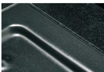
Silikonieren: Wird das Silikon nach dem Auftrag abschließend glattgezogen, bleibt eine dichte, nahezu unsichtbare Fuge zwischen Naturstein und Keramik.
