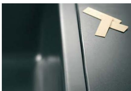
Justieren: Um rundum einheitliche Höhen fein zu justieren, werden mitgelieferte Millimeter-Holzspatel von unten zwischen Verlegeband und Spülrand geklemmt.
