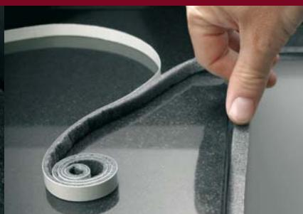
Einkleben: Einlegen des selbstklebenden Flex-Verlegebandes, das werkseitig mitgeliefert wird. Auflegen und andrücken. Auf diese Weise entsteht zusätzlich eine Silikonsperrre.
